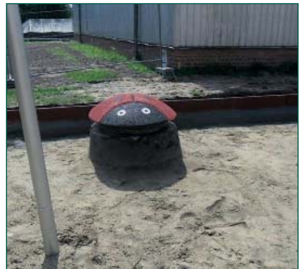
Kanaldeckel inmitten des Spielplatzes...
