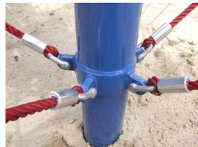
13. Jetzt kann das Gerät ausgerichtet werden. Dazu müssen alle Spanschlösser gespannt werden.
